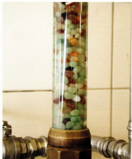
Links sind die an der Rückseite der Teigmacherei angebrachten Module von Elisa zu sehen. Das mit Edelsteinen gefüllte Modul direkt an der Verriegelung dient eher publikumswirksamen Effekten als der Wasserqualität.
